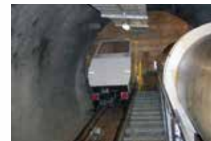
2002 Plan incliné, centrale hydro-électrique Maen – Italie
