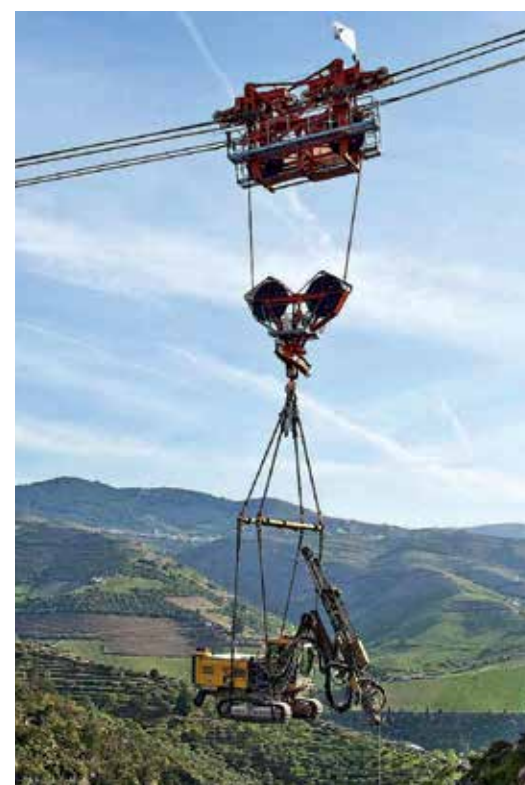
TRANSPORT AÉRIEN Les installations à câble constituent souvent la solution idéale pour la manutention des équipements lourds à l'intérieur des chantiers complexes.
